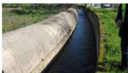
Tramo encauzado de aguas en Cáceres y sobre el que se actuará Miteco
