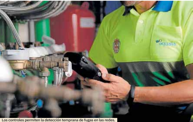
Los controles permiten la detección temprana de fugas en las redes.
